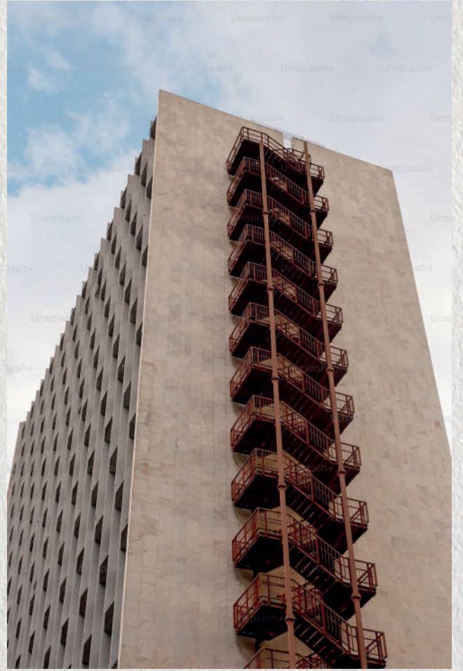
Yangın Merdiveni Kurulumu
